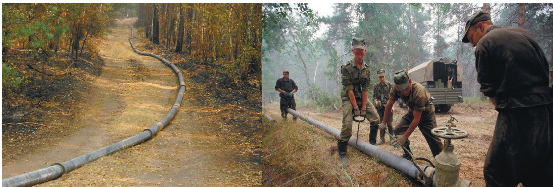
Рис. 2. Общий вид сборно-разборного трубопровода ПМТП-150 и его сборка
