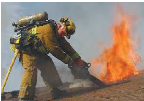
Рис. 3. Создание вытяжного отверстия с помощью кровельной пилы на мягкой кровле
