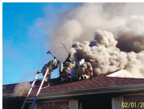
Рис. 4. Создание вытяжного отверстия с помощью ручного инструмента на мягкой кровле
